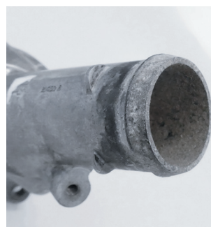
Ilustracja 3: Przed montażem staranne oczyszczenie skorodowanej powierzchni
